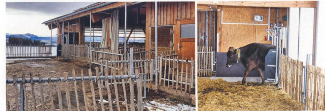
Der Kälberstall hat zwei Bereiche, ein Laufhof schließt sich an. Mit Kabelbindern ist der leichte StakeNZaun an die Stahlrohre der Abtrennung montiert.
